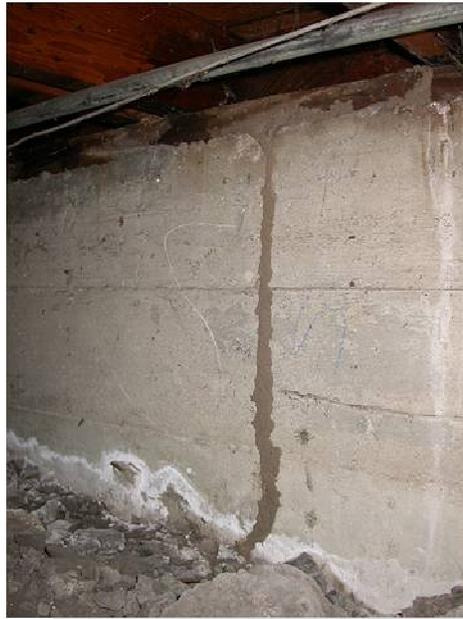
*Túnel de protección de termitas subterráneas en una fundación de hormigón.
