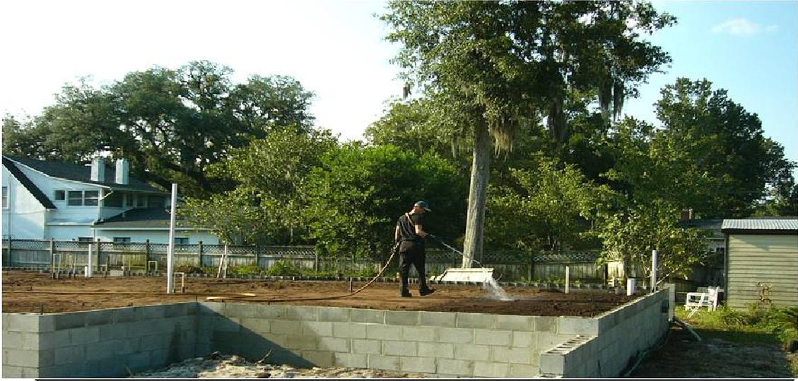
*Fumigación con termicida antes de verter el hormigón de radier en el terreno nivelado*
